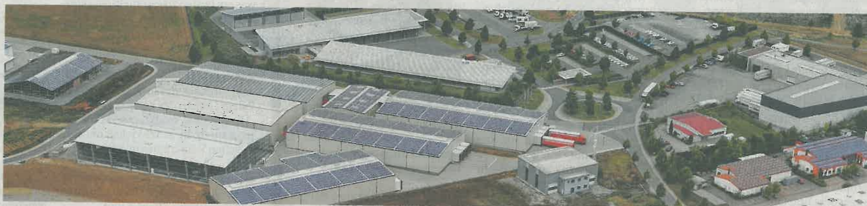
Im November nimmt die Spedition Rüdinger den aktuellen Bau in Windischbuch mit 2600 Quadratmetern und 8000 Palettenplätzen in Betrieb.
